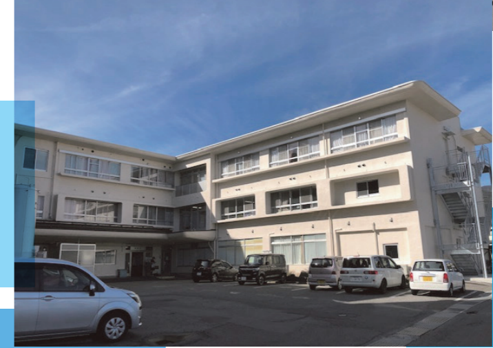
減築・耐震改修後
